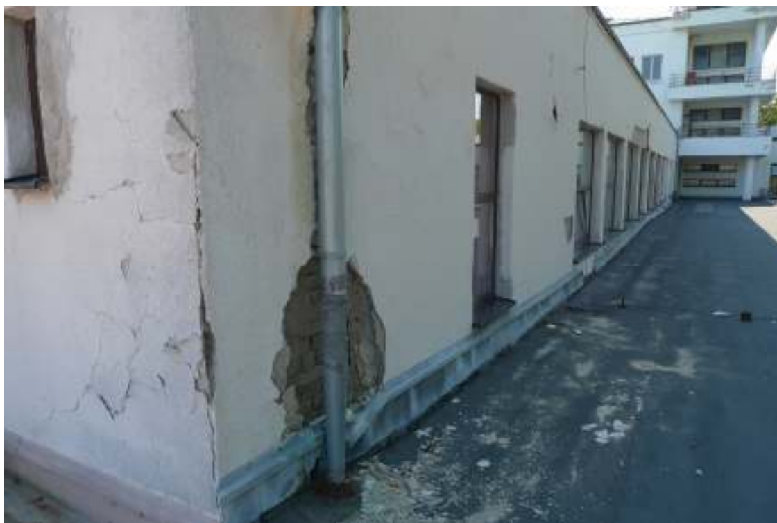
Terasy prepúšťajú vodu a poškodzujú strop a murivo.
