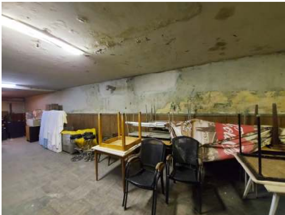
Stena a strop suterénu poškodené presakujúcou vodou.
